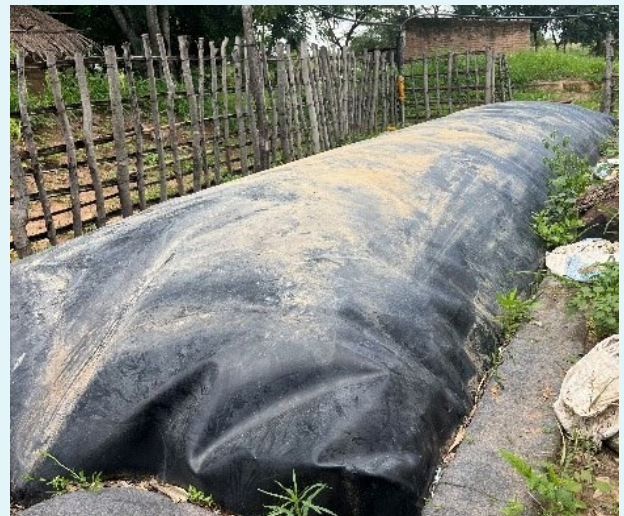
Biogas digester at Umodzi Poultry
